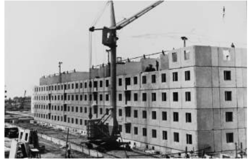
Строительство пятиэтажного жилого дома. Город Волжский
