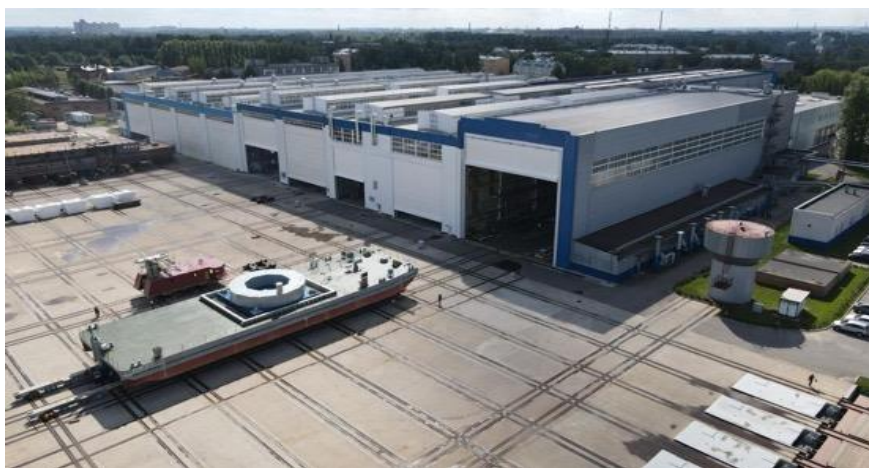
Рисунок 10 – Производственное помещение для изготовления крупногабаритных магнитных систем
